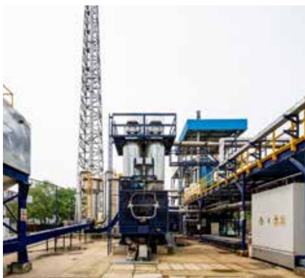
L'Omniprocasseur, une technologie innovante de valorisation des boues de vidange et des déchets organiques en eau, énergie et sous-produits à forte valeur ajoutée.
